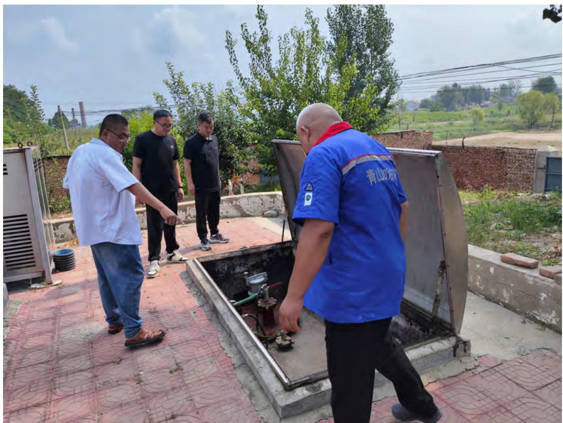
曹县郑庄乡青山加油站现场照片
