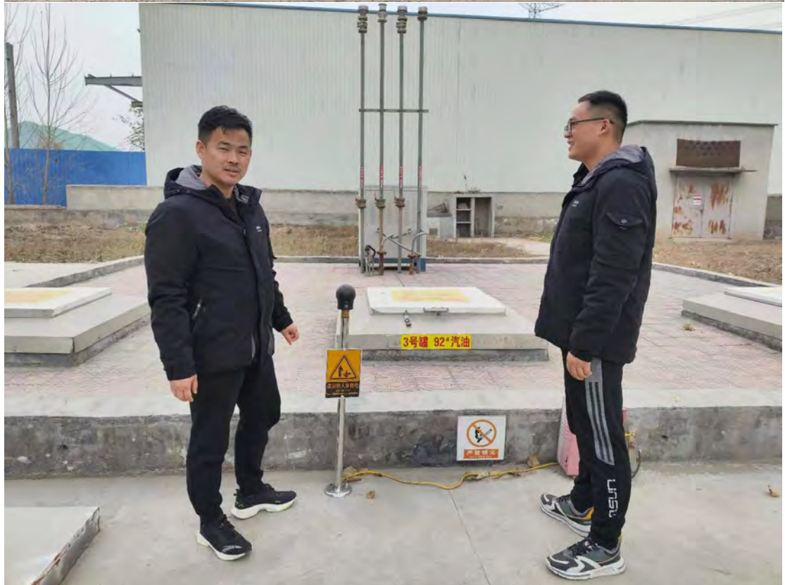
富海能源有限公司巨野获麟加油站现场照片
