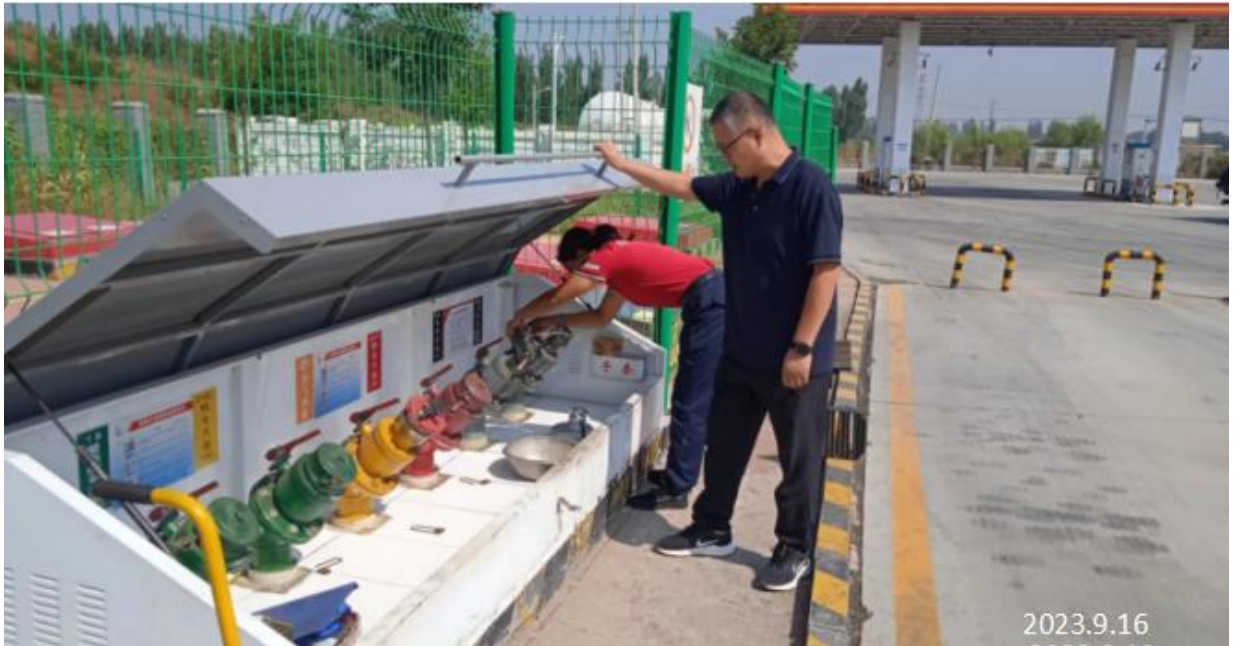
加油站现场照片
