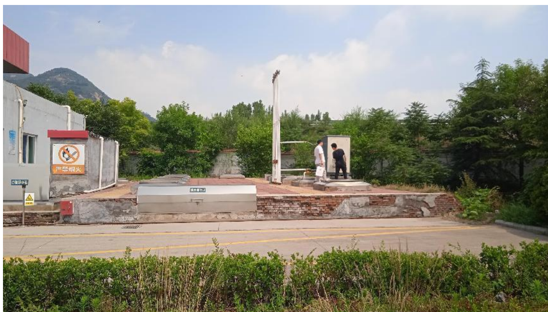
加油站现场照片
