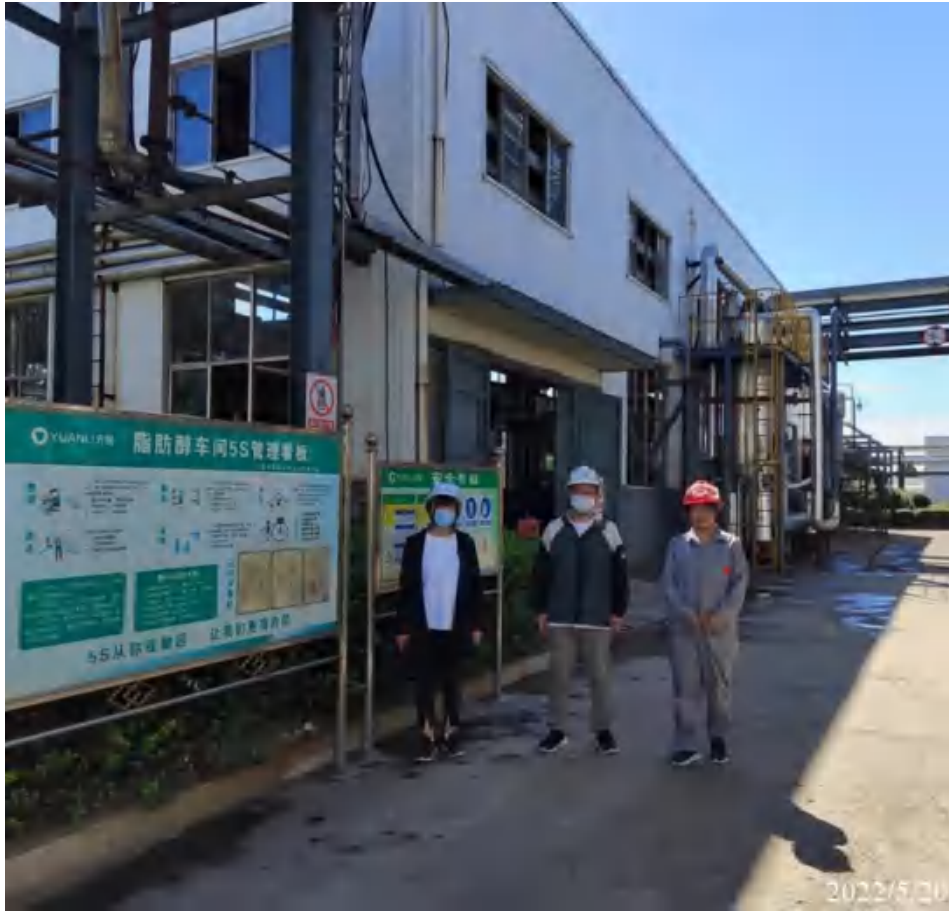
山东元利科技有限公司 6 万吨/年脂肪醇装置现场照片
